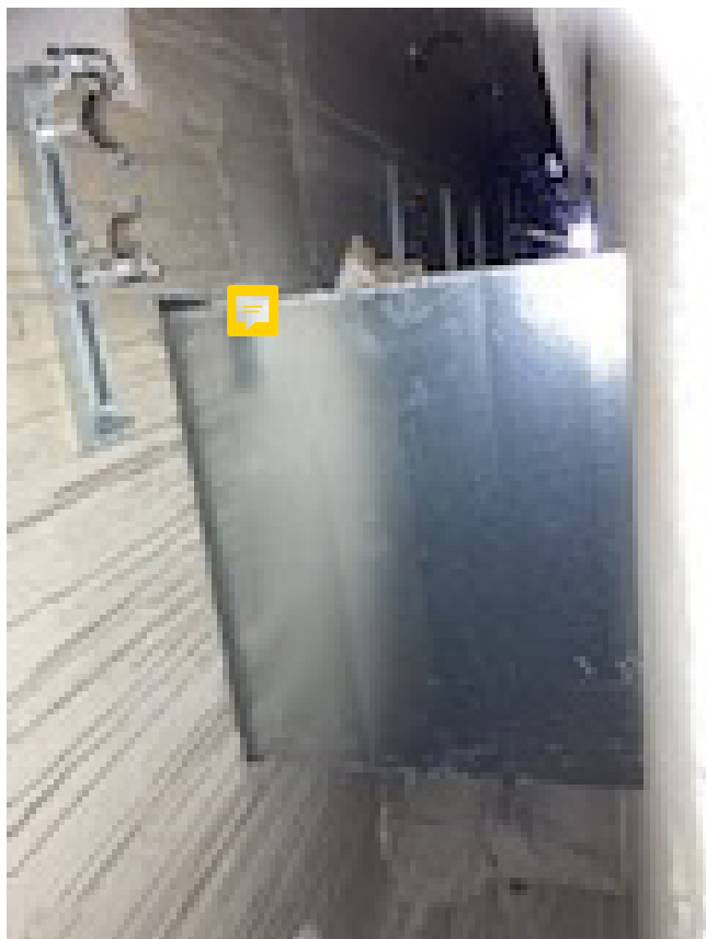
6. ÁBRA: SZERELHETETLEN POZÍCIÓBA TERVEZETT TŰZGÁTLÓ LÉGCSATORNA-BURKOLAT
