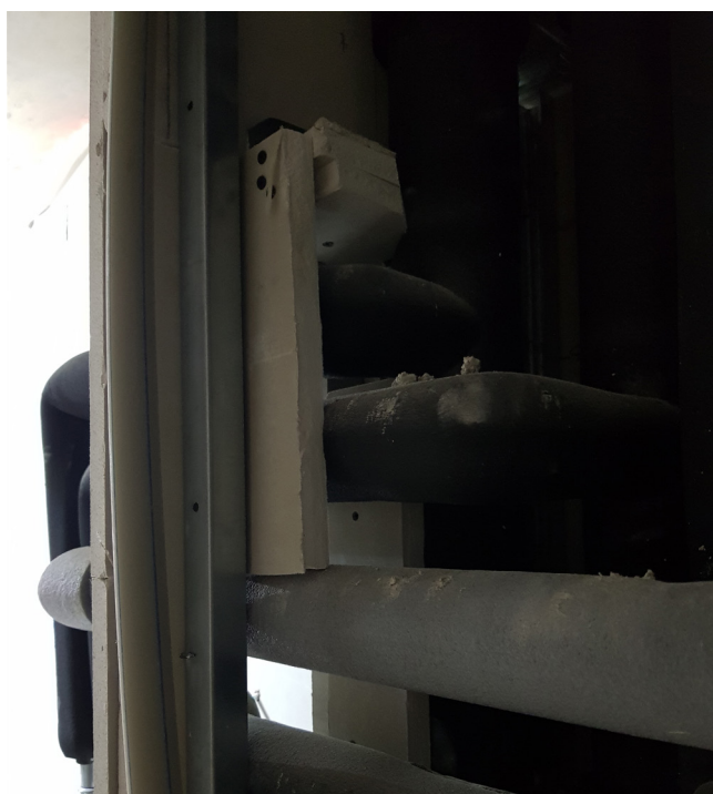
4. ÁBRA: HIÁNYOS KERETEZÉS KÖNNYŰSZERKEZETES AKNAFALON
