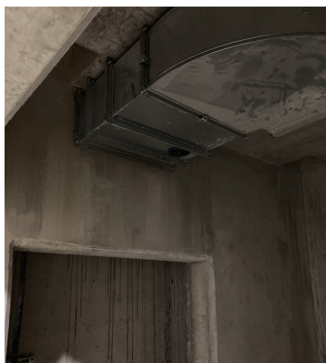
5. ÁBRA: SZERELHETETLEN POZÍCIÓBA TERVEZETT TŰZGÁTLÓ LÉGCSATORNA-BURKOLAT
