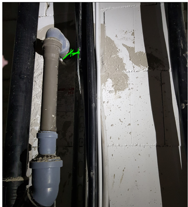
3. ÁBRA: 1,5-2 CM HELY MARADT A CSATORNAVEZE- TÉK ÉS A VILLAMOS FELSZÁLLÓ KÖZÖTT
