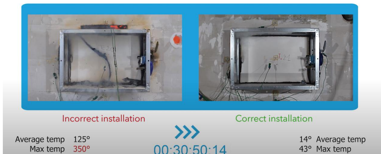
1. ábra - Ugyanannak a tűzvédelmi csappantyúnak a tűzvizsgálata egyszer szabályos beépítéssel, egyszer pedig apró beépítési hibákkal - a teljesítőképesség különbsége egyértelmű
