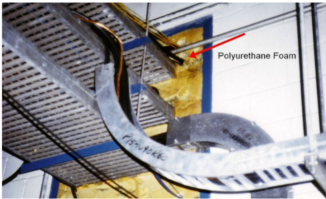
PUR HABBAL KITÖLTÖTT KÁBELÁTVEZETÉS AZ ATOMERŐMŰBEN
