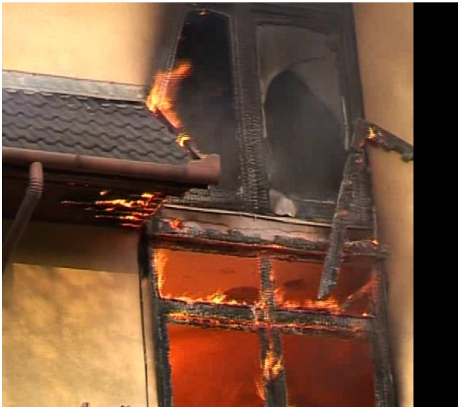
4.15. ábra – A tetőszerkezet önfenntartó égéssel ég – tűzkeletkezéstől számított kb. 19. perc (képanyag: Gottwald Károly, Tolnai Népújság)
