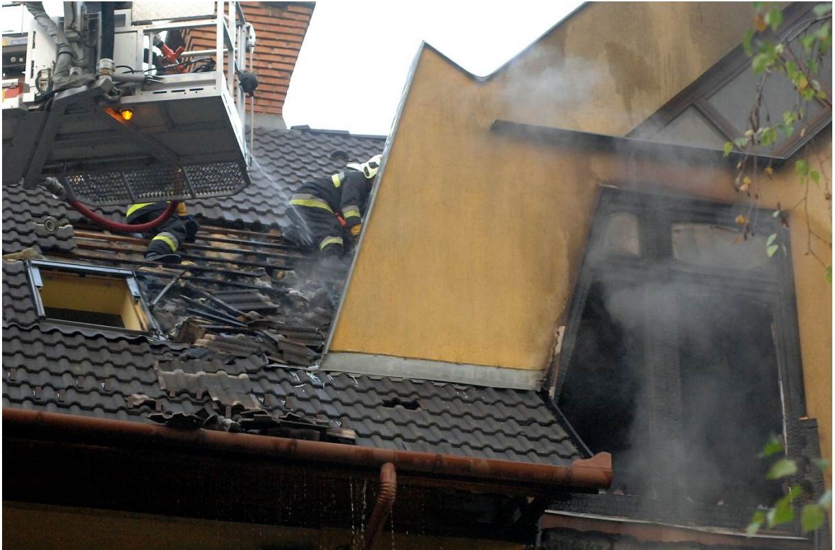
4.17. ábra – Oltás érdekében megbontott tetőszerkezet (képanyag: Gottwald Károly, Tolnai Népújság)
