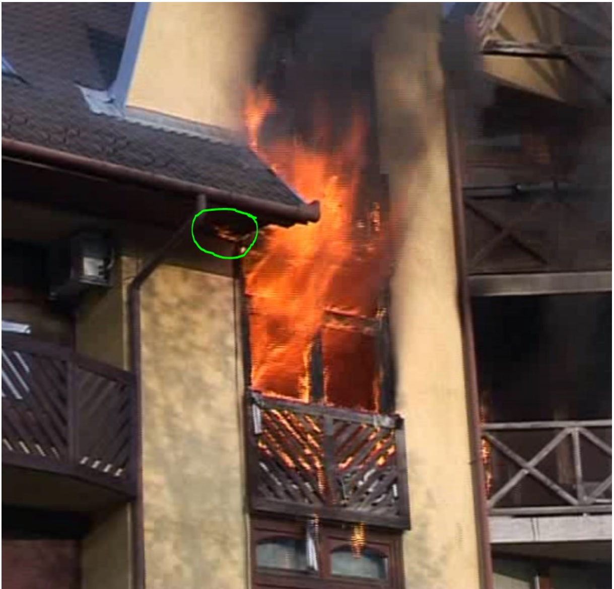
4.14. ábra – Homlokzati tűzterjedés az első beavatkozó szer kiérkezésekor – tűzkeletkezéstől számított kb. 12. perc (képanyag: Gottwald Károly, Tolnai Népújság)
