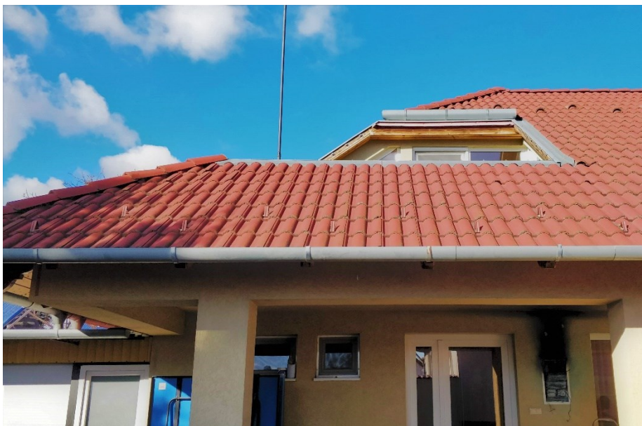
4.11. ábra – A homlokzattól visszahúzott villanyóra szekrény – az eresz „védett” helyzetben
