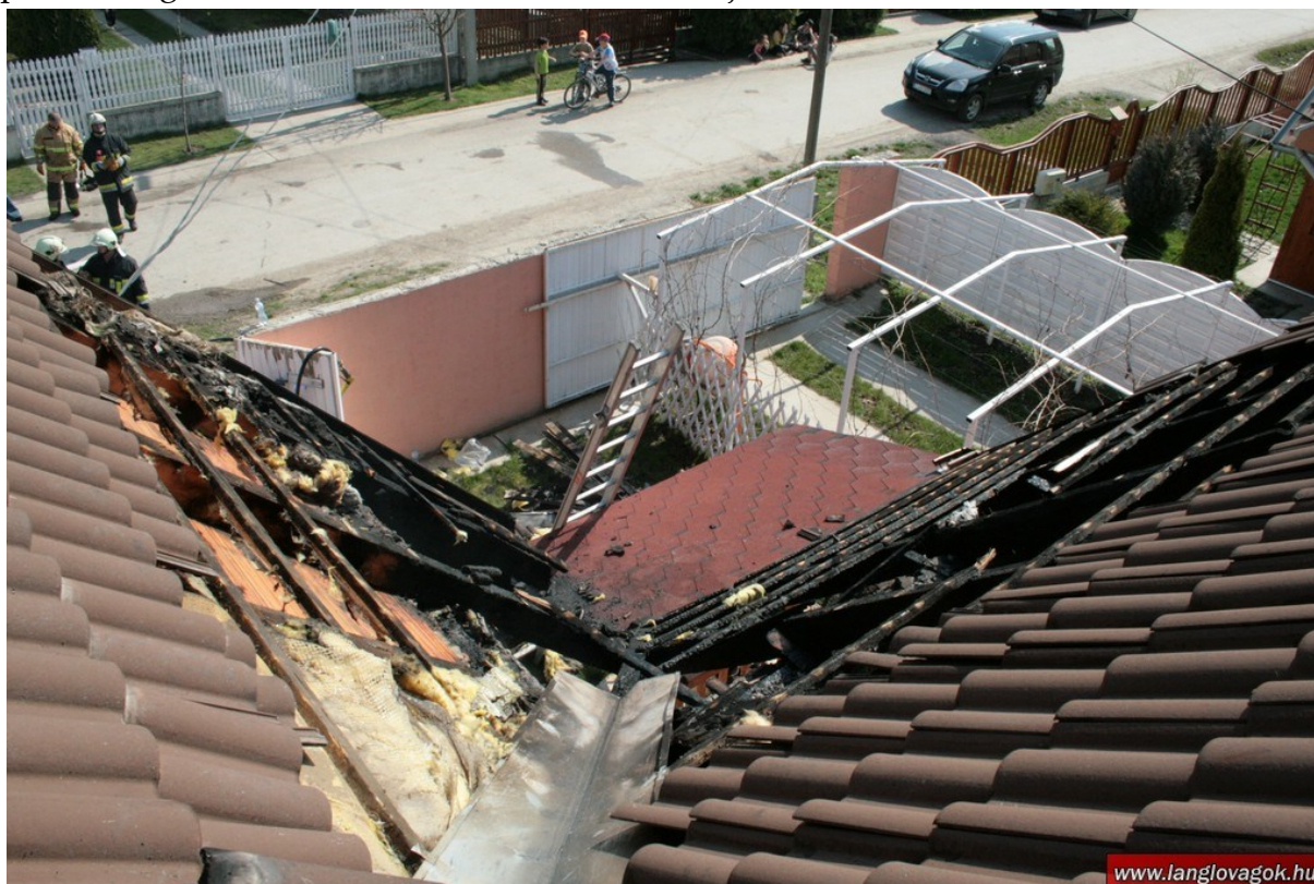
4.5. ábra – Oltás érdekében megbontott tetőszerkezet (forrás: www.langlovagok.hu )
