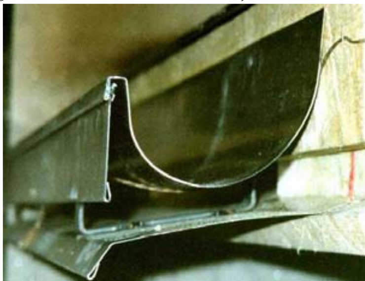
3.29. ábra – Kettős eresz kialakítása [Jukka et al. 2013]
