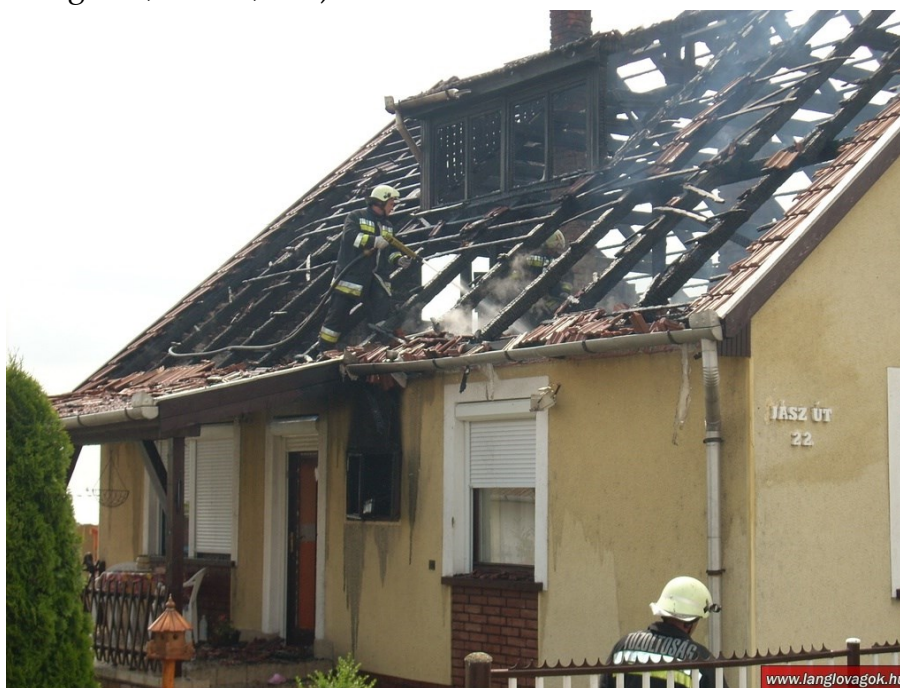
3.5. ábra – Villanyórában keletkezett tűz miatt leégett tetőszerkezet (forrás: langlovagok.hu)
