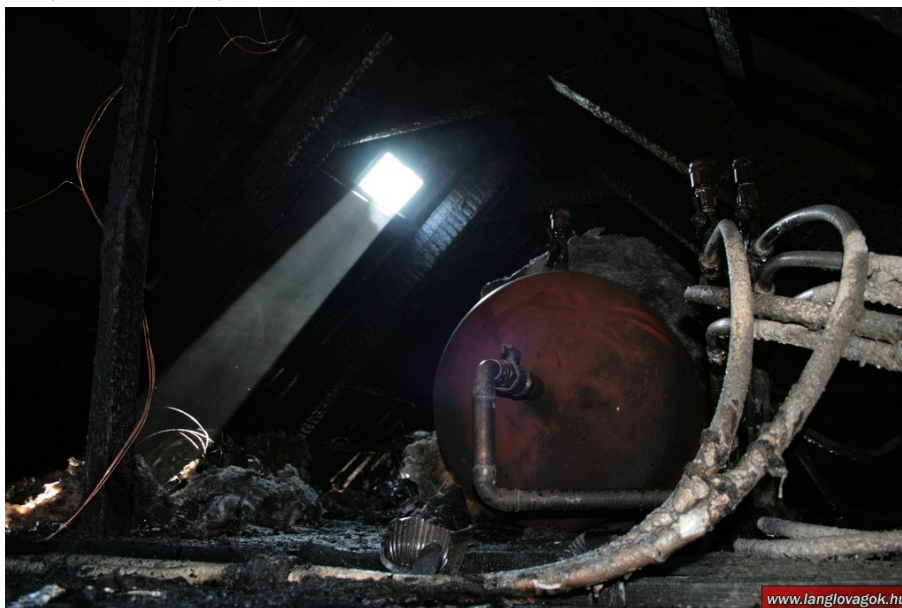
4.3. ábra – Kiegett padlástér épületgépészeti puffertartállyal (forrás: www.langlovagok.hu )
