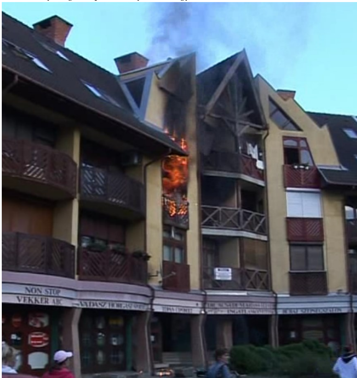
4.13. ábra – Homlokzati tűzterjedés az első beavatkozó tűzoltó egység kiérkezése előtt kb. 1 perccel – tűzkeletkezéstől számított kb 11. perc (képanyag: Gottwald Károly, Tolnai Népújság)
