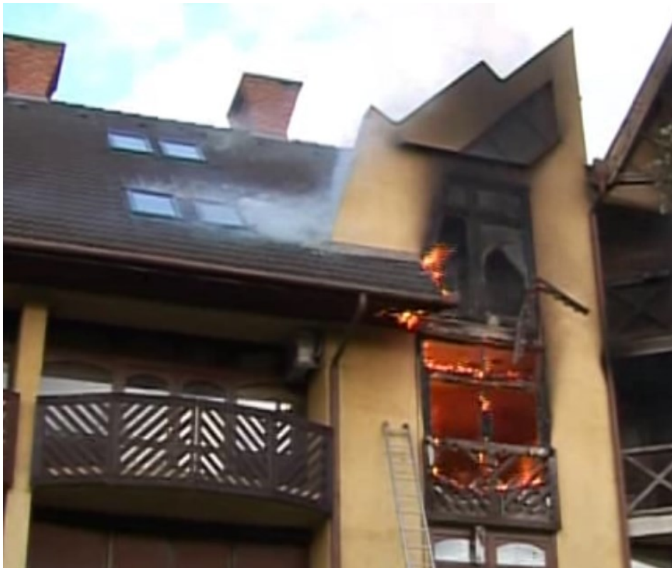
4.16. ábra – A tetőszerkezet másodpercekkel a beavatkozás megkezdése előtt – a tűzkeletkezéstől számított kb 20. percben (képanyag: Gottwald Károly, Tolnai Népújság)
