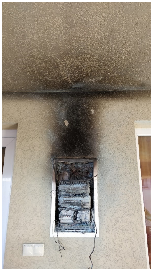
4.10. ábra – Nem megfelelően karbantartott villanyóra szekrény tüze (fotó: Kiss Viktória)
